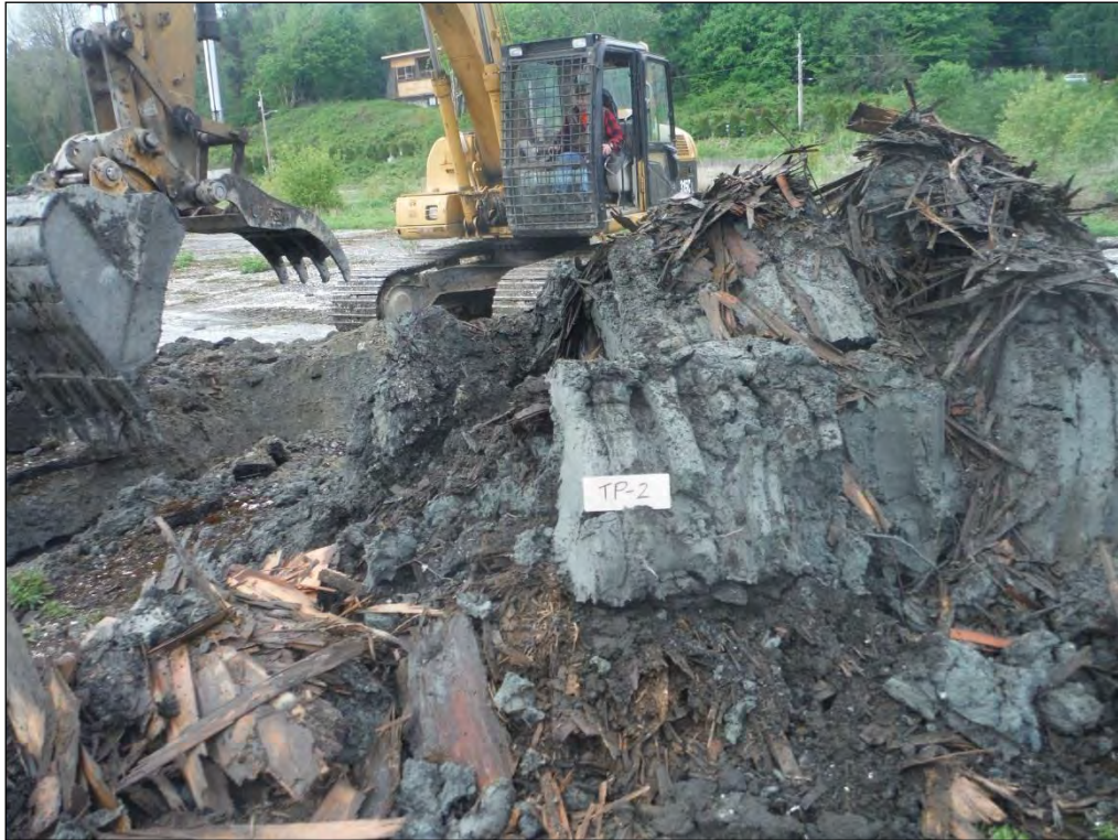
5. Test pit TP-2.
