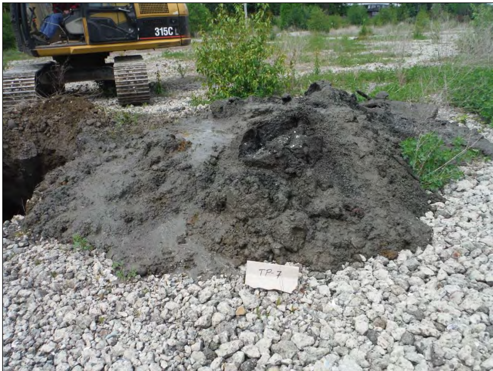
18. Test pit TP-7.
