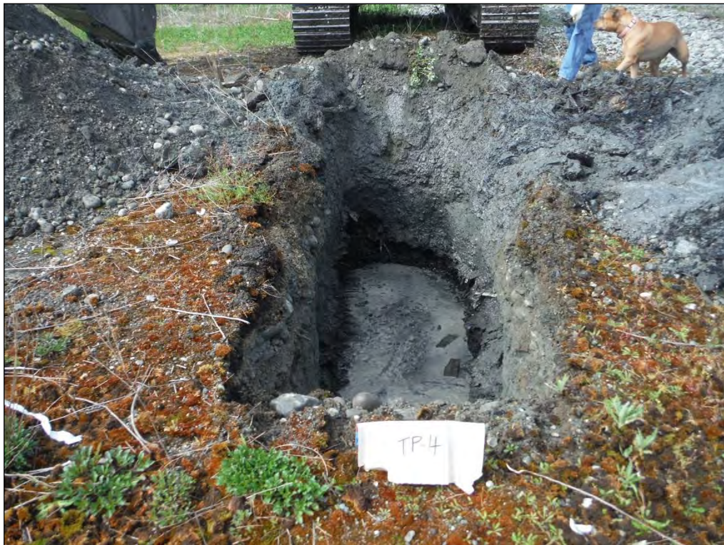
12. Test pit TP-4.
