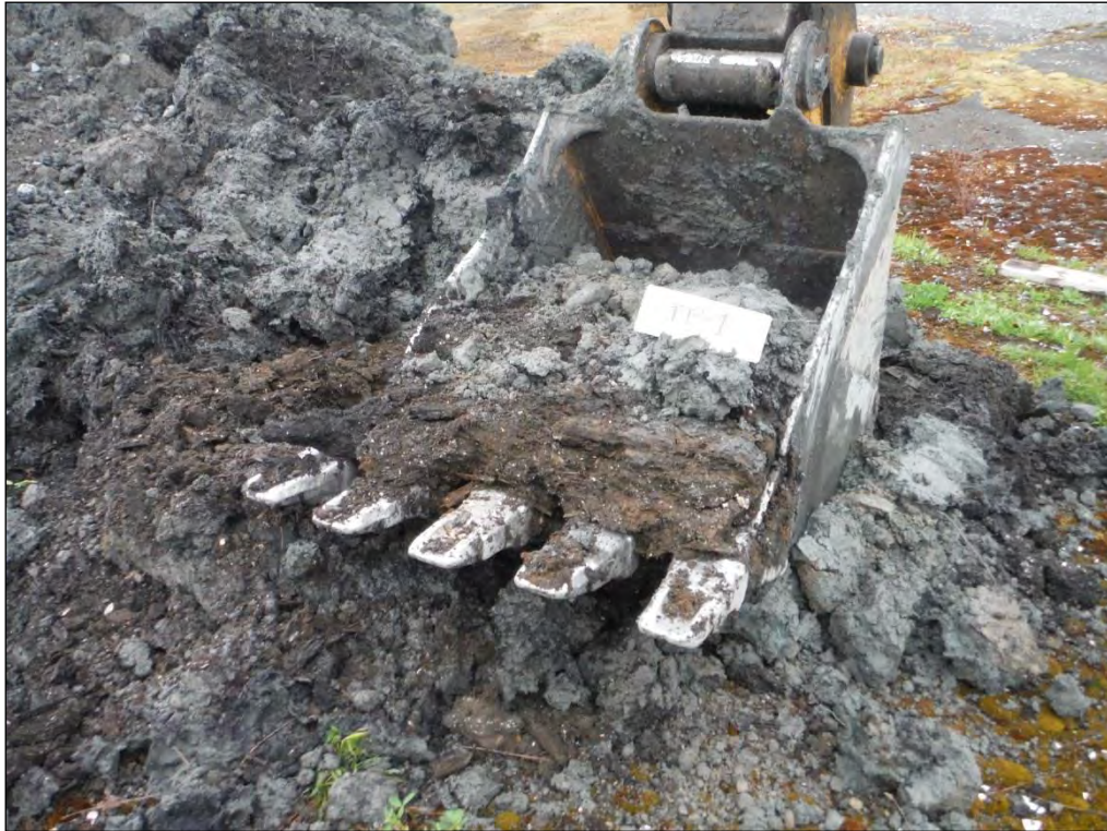
3. Test pit TP-1.
