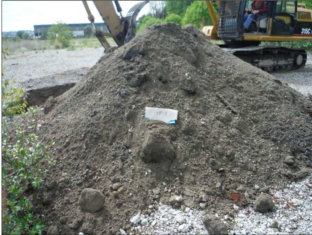
15. Test pit TP-5.
