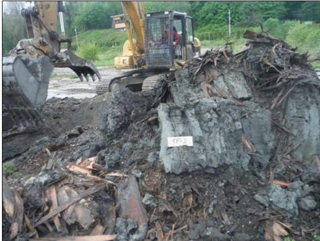
5. Test pit TP-2.
