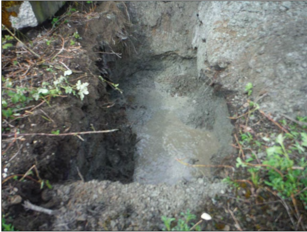
7. Test pit TP-3.
