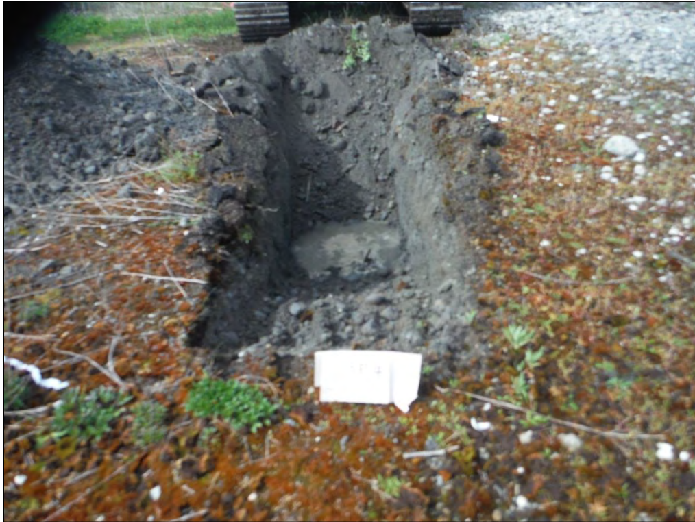
9. Test pit TP-4.
