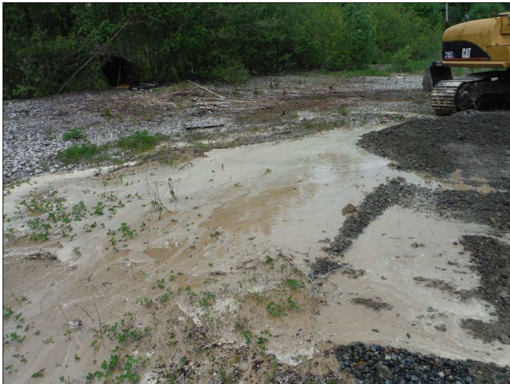
16. Test pit TP-6.
