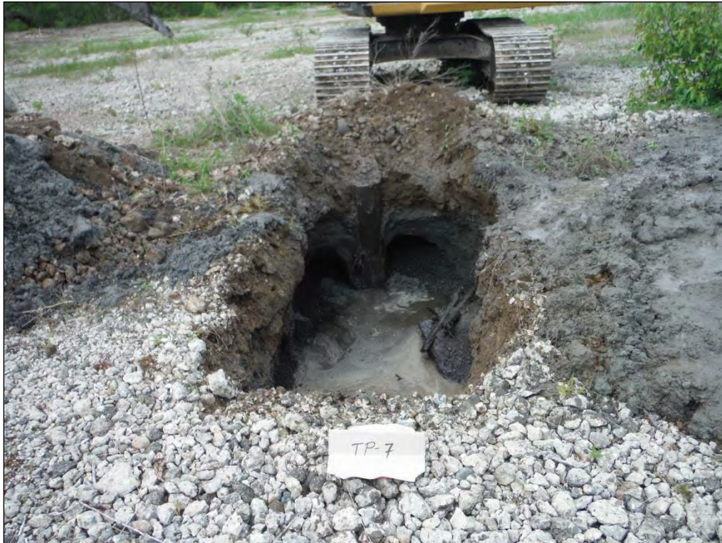
17. Test pit TP-7.
