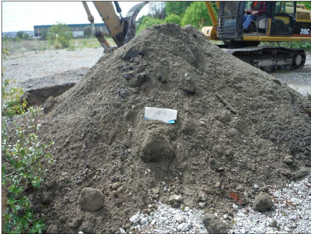
15. Test pit TP-5.
